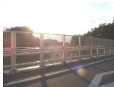
中央高速を渡る橋
