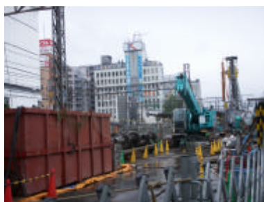
地下化工事が進む
